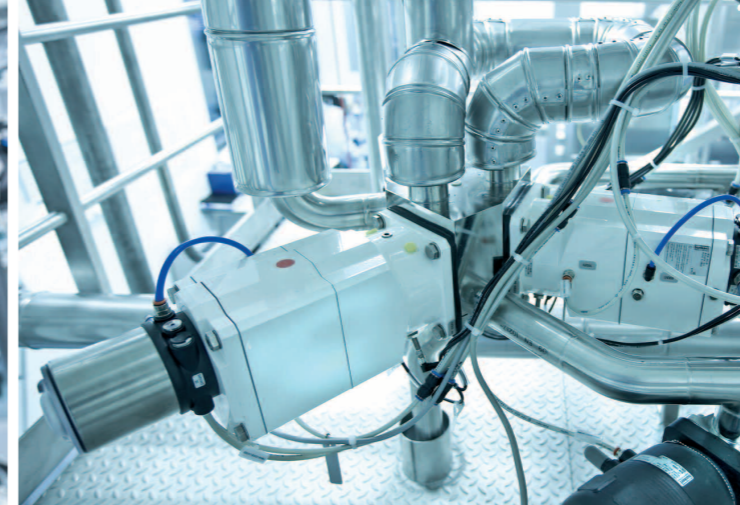
Actionneur Robolux combiné à un positionneur type 8696 pour la régulation de la vapeur.
